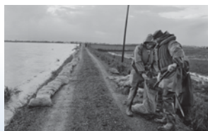
Levee Sandbagging
